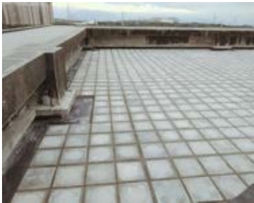
▼ 各大樓頂樓隔熱磚鋪設
