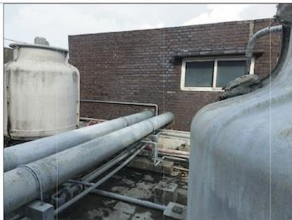
RF 動物中心冷卻水塔配管現場狀況
