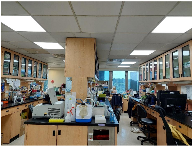
圖二：醫學院各實驗室汰換原本的 T5 燈具更換為 LED 燈具
