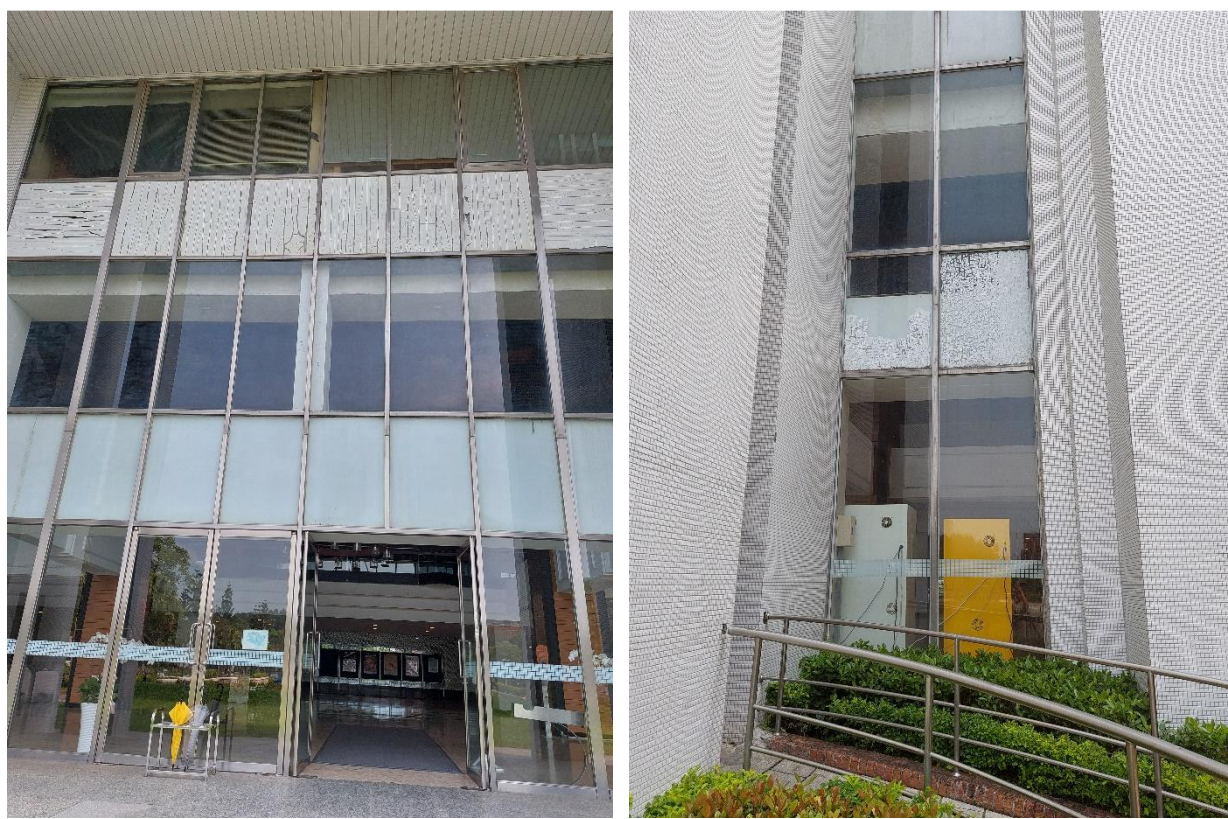
圖五. 第一醫學大樓正門口(左)及側邊(右)上方之隔熱紙已經斑駁。
