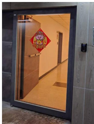
後門加裝自動感應門，避免常開，冷氣外漏
